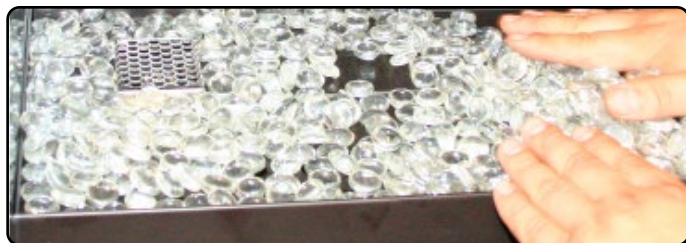
Figure 24. Répartition des braises de verre
