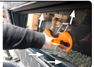
Figure 21.b Installer la porte
