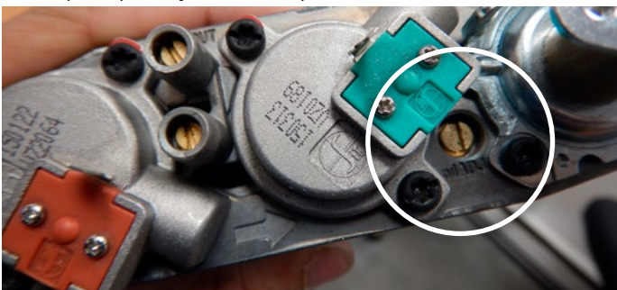
Figure 13.g Ajuster la taille du pilote
