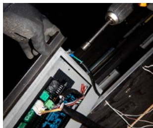
Figure 24.b Retirer le tableau de base existant
