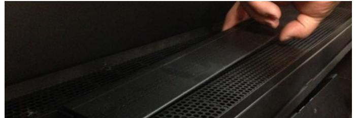
Figure 13.b Déserrer le venturi
