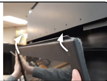
Figure 21.b Installation de la porte
