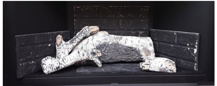
Étape 5 : La bûche D est placée en diagonale directement devant la bûche A avec une extrémité placée au milieu du plateau de support
