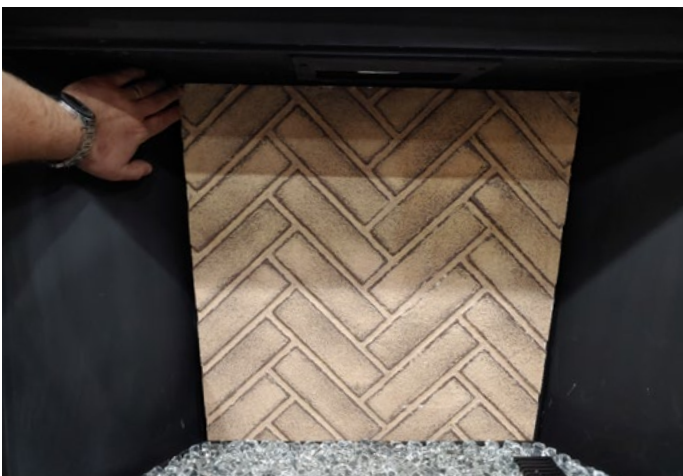
Figure 20.b Maintenez-le en place ou fixez-le à l'aide de ruban de masquage
