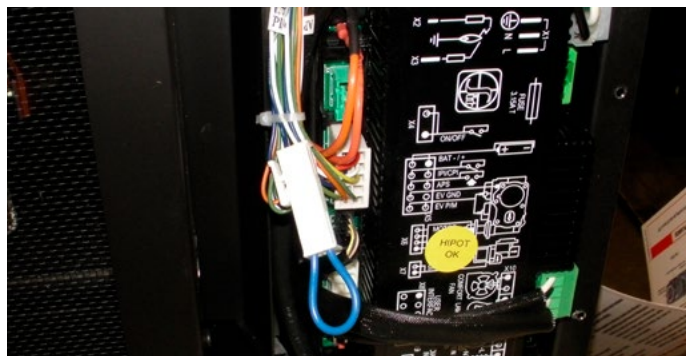
Figure 6.2 Connexion du câble de raccordement CPI
