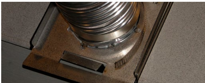
Figure 3.2 Plaque coulissante du système de ventilation
