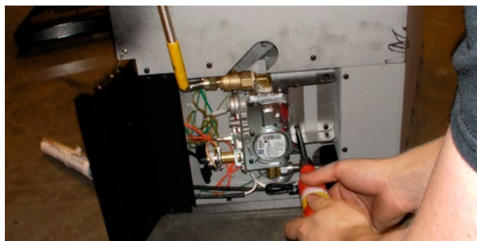
Figure 4.2 Trousse de conversion au propane illustrant l'obturateur de la veilleuse et l'obturateur du brûleur principal
